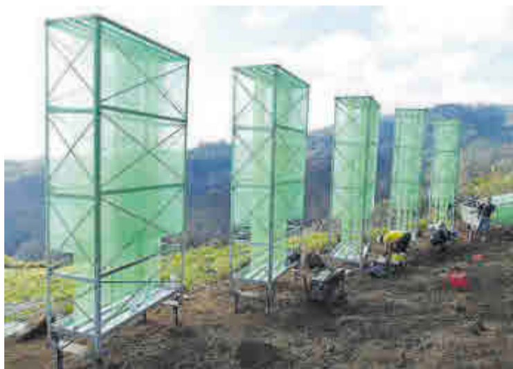
Técnicos de Gesplan durante la instalación de los aparatos. | LP/DLP
